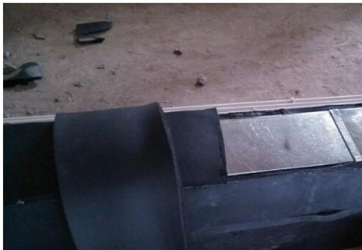
管道外包橡塑保温板，隔音隔热。
