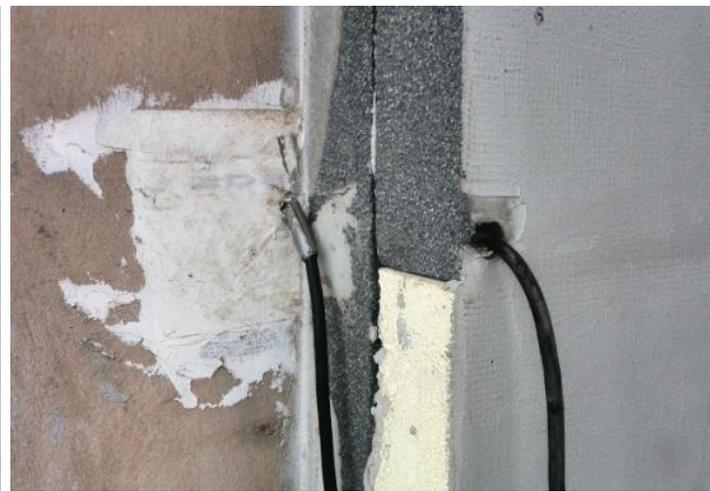
管线穿墙面外封橡塑保温膜。
