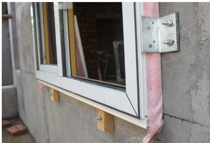
门窗外挂式安装，两侧角钢固定、底部使用防腐处理的木块承托。
