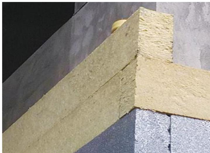
楼层之间使用岩棉板设置防火隔离带
